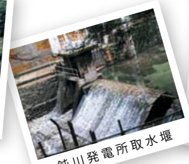
鈍川発電所取水堰
