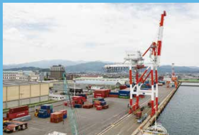
今治港富田ふ頭コンテナターミナル
